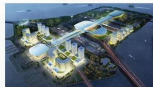
港珠澳大桥珠海口岸
